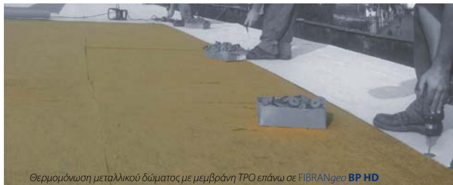
Μεταλλικό δώμα με στεγανοποίηση μεμβράνης επάνω σε διπλή στρώση FIBRANgeo BPBP 30 + BP HD
