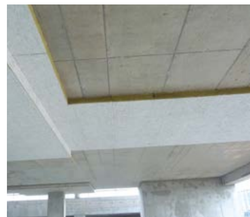
Εμφανής εσωτερική μόνωση μεταλλικού δώματος με FIBRANgeo B-570-AX
