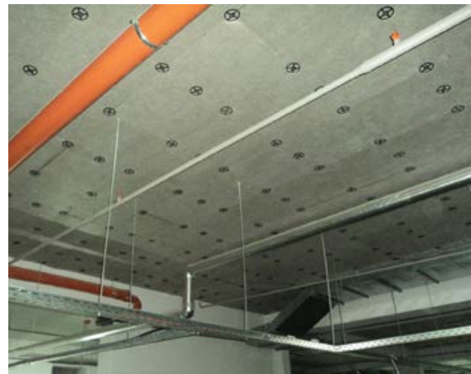
Θερμομόνωση οροφής υπόγειου χώρου στάθμευσης με FIBRANgeo B-570-YA
