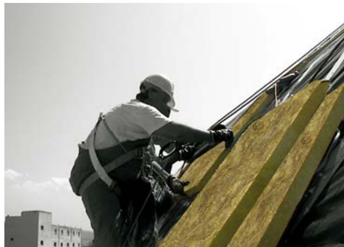
Θερμομόνωση κεκλιμένης στέγης μεταξύ δυο μεταλλικών φύλλων επιστέγασης με διπλή στρώση πετροβάμβακα FIBRANgeo BP 40 + BP 50
