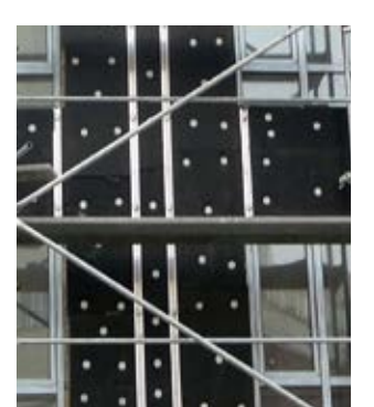
Αεριζόμενη όψη με FIBRANgeo B-570-YM
