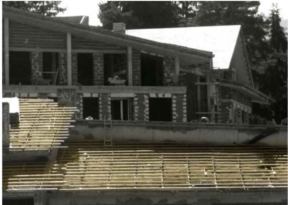
Θερμομόνωση μεταξύ των δοκίδων της στέγης με FIBRANgeo R-050
