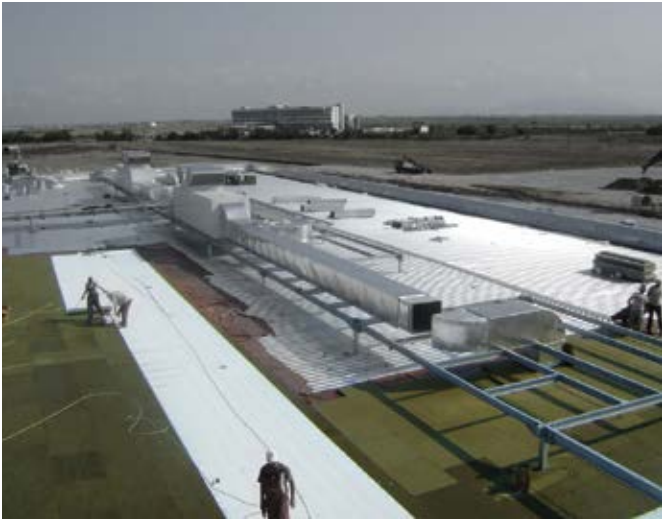
Μεταλλικό δώμα με στεγανοποίηση πολυμερούς μεμβράνης επάνω σε FIBRANgeo BP 70
