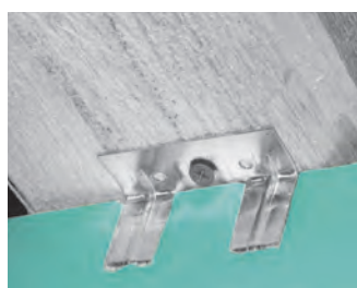
Διαδικασία εφαρμογής θερμομόνωσης FIBRANxps MAESTRO με μη εμφανή στηρίγματα
