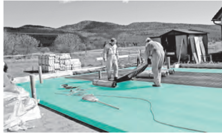
Κατασκευή Βιομηχανικού δαπέδου με FIBRANxps 500
