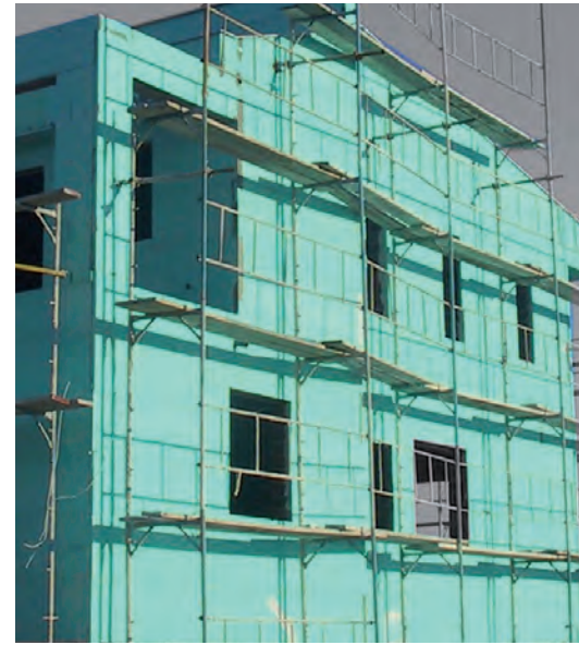
Εξωτερική θερμομόνωση με FIBRANxps ETICS GF
