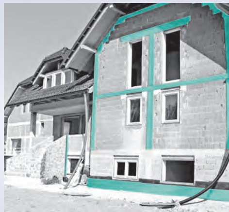
θερμογεφυρών στοιχείων σκυροδέματος
